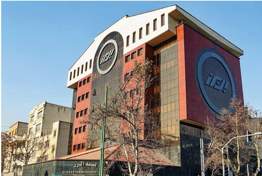
شکل ۱. ساختمان ستاد مرکزی بیمه البرز (ساختمان شریعتی)
