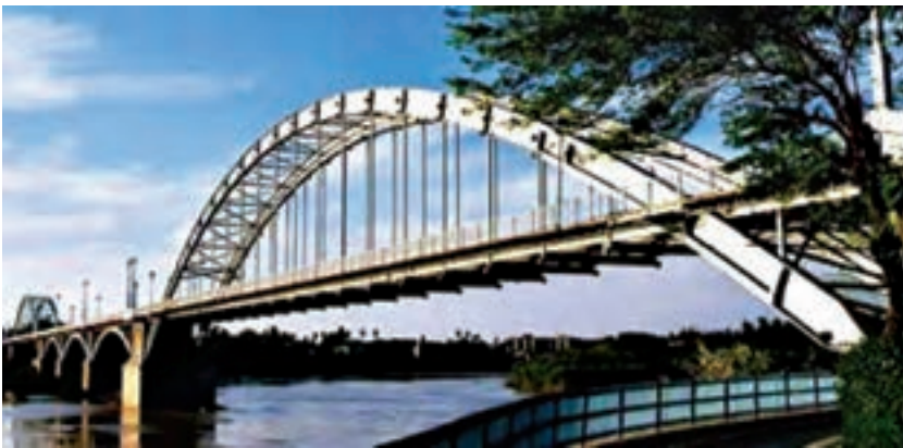
شکل ۱۱- پل معلق اهواز
