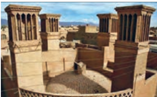
شکل ۲۷-۱۲ - یک نمونه بادگیر مناطق کویری
