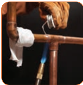
لجیم کاری نقره در لوله مسی
