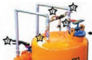
۱ و ۲- شیرهای برگشت (By pass)، ۳ و ۴- شیرهای ورودی و خروجی مخزن ۵- شیر فلکه روی لوله اصلی
