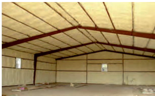
عایق‌بندی سقف و دیواره
