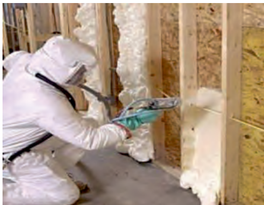
عایق‌بندی با نوعی فوم خمیری
