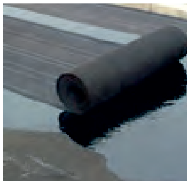
عایق کاری سالن پاستوریزاسیون
