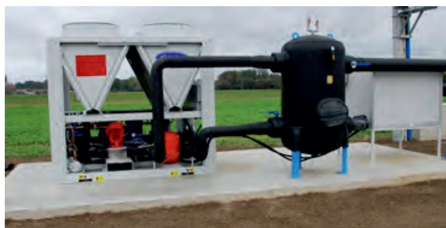
سیستم خنک‌کننده یک تولیدی قارچ دکمه‌ای
