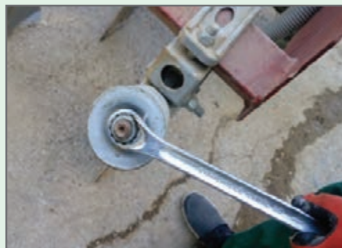
شکل ۴۵- آچار کشی نقاط اتصال اجزا و قطعات
