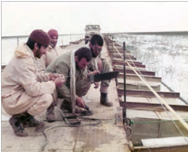
ساخت پل شناور خیبر بر روی هورالعظیم یکی از شاهکارهای مهندسی رزمی جهادگران در دوران دفاع مقدس بود.
