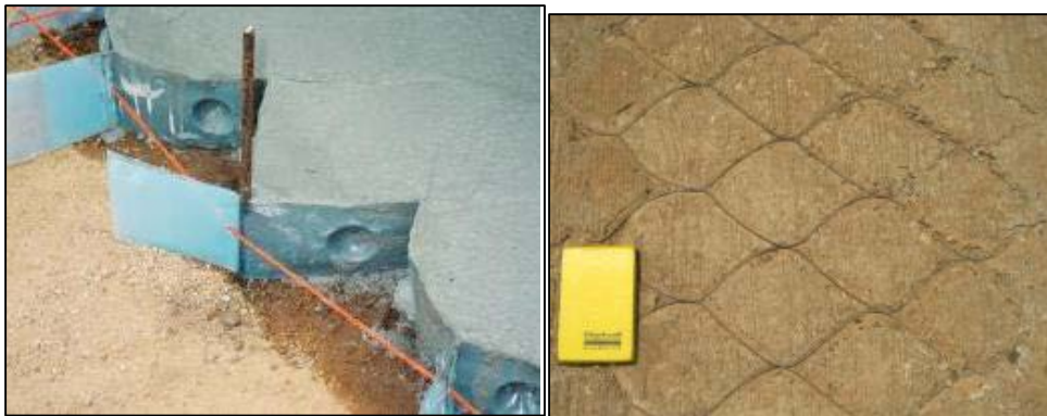
شکل ۶-۳۵- نمونه‌ای از رویه بتنی همراه با ژئوسل
