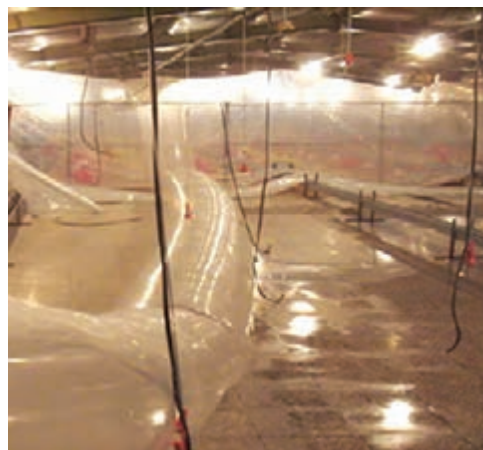
۳ کانال پلاستیکی هوای گرم و مرطوب در روی زمین
