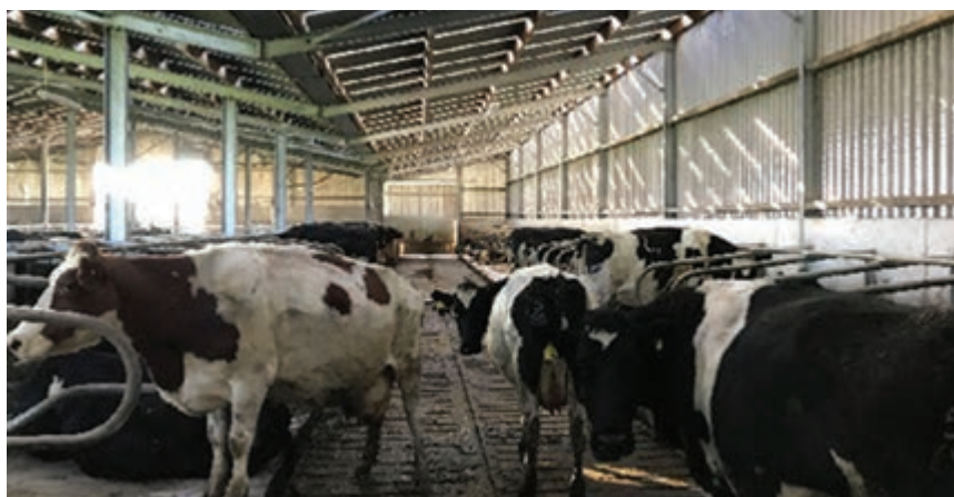
استفاده از کف مشبک در جایگاه
