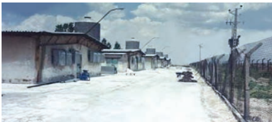
شکل ۱- حصارکشی اطراف سالن‌های مرغداری
