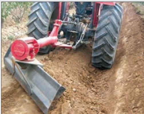
شکل ۲۷-۲ زاویه تیغه و ریزش خاک در چاله
