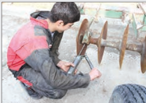
شکل ۲۱-۴- گریس کاری دیسک
