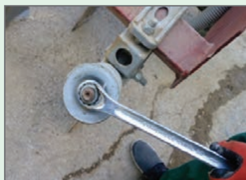
شکل ۴۵- آچارکشی نقاط اتصال اجزا و قطعات
