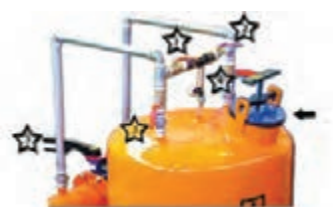
شکل ۲۷- اتصال مخزن کود به لوله اصلی
