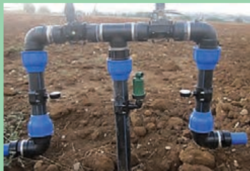
شکل ۱۸- شیر و فشارسنج روی بال ها
