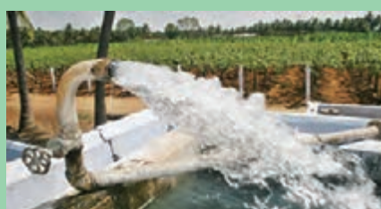
شکل ۱۶- لوله برگشت آب
