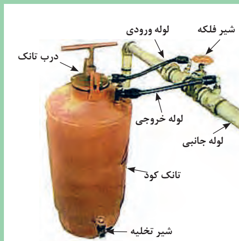
شکل ۳۳- اجزای سیستم توزیع کود
