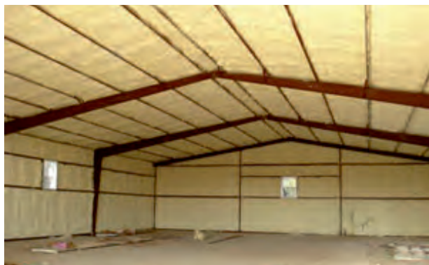
عایق‌بندی سقف و دیواره
