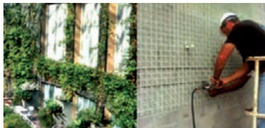
نصب پانل‌ها روی دیوار
