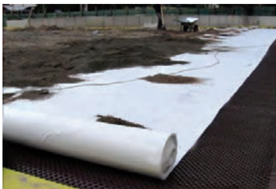
قرارگیری رول ژئوتکستایل در زیر بستر رشد
