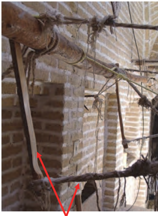
شکل ۳۶- کُمونه و نخ اتصال آن
