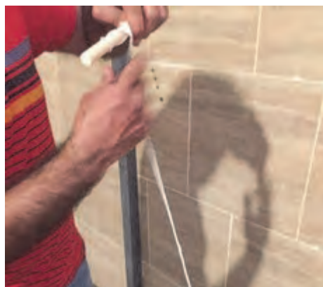
شکل ۶۷- پیچیدن نخ ها روی چوب ماسوره
