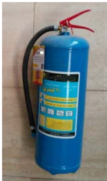
شکل ۱۱- کپسول آتش‌نشانی حاوی مخلوط آب و گاز
