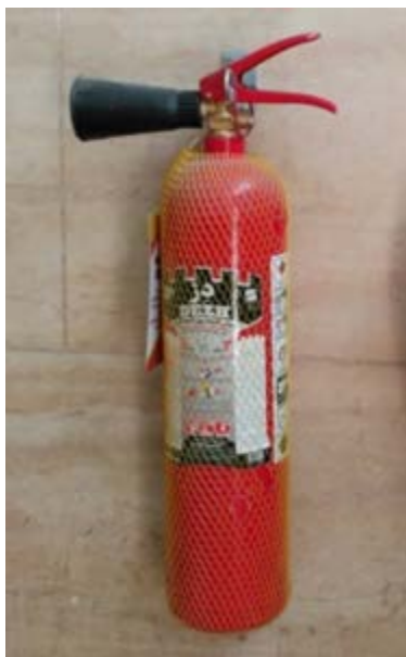
شکل ۱۲- کپسول آتش‌نشانی حاوی خاموش‌کننده دی‌اکسید کربن
