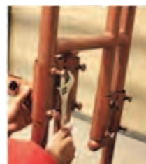
شکل ۱۸- بستن پیچ‌های قطعات دستگاه
