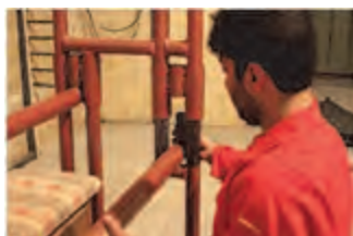
شکل ۱۷- نصب اجزاء دستگاه
