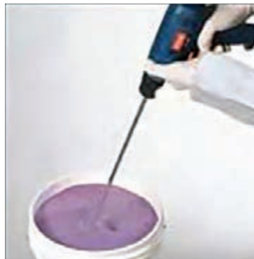
مخلوط کردن لعاب با استفاده از همزن
