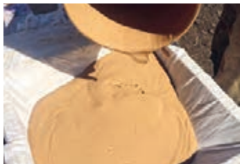
شکل ۳۹- آب گیری دوغاب
