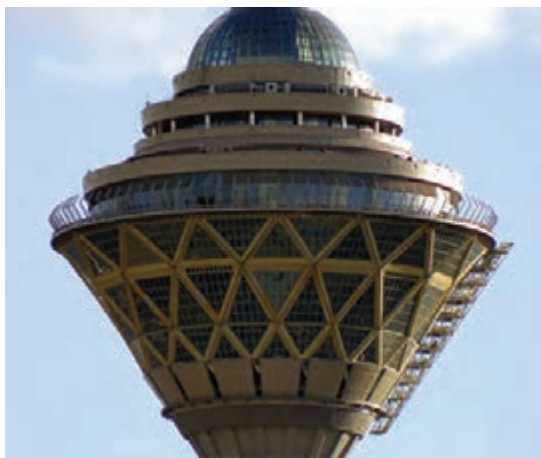
شکل ۲- سازه فلزی برج میلاد تهران
