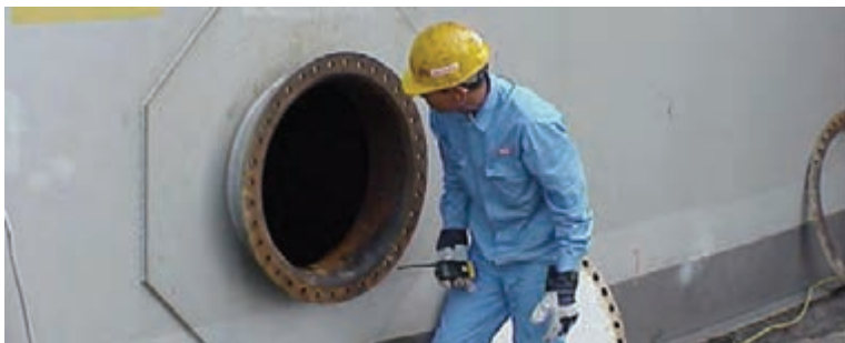
شکل ۲۲- دریچه آدمرو مخزن
