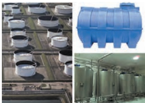
شکل ۱۵- مخزن ذخیره‌سازی استوانه‌ای کم فشار
