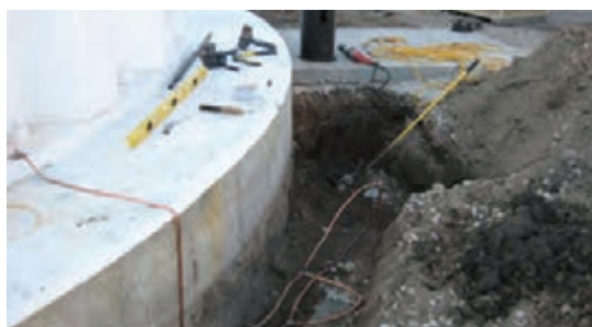
شکل ۲۶- تخلیه الکتریسیته ساکن بدنه مخزن به زمین
