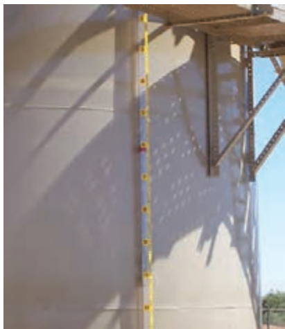
شکل ۲۳- ارتفاع سنج مغناطیسی روی مخزن
