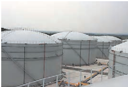
شکل ۱۷- مخازن سقف ثابت: (سمت راست) سقف گنبدی و (سمت چپ) سقف مخروطی
