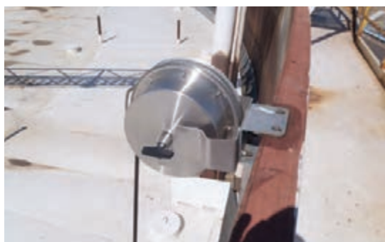
شکل ۲۷- تخلیه الکتریسیته ساکن در مخزن سقف شناور
