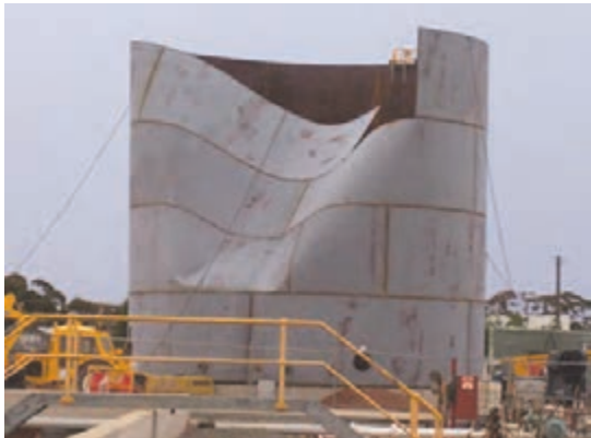
شکل ۲۸- آسیب دیدن مخزن به دلیل وزش باد
