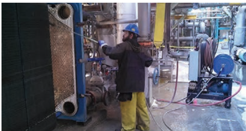
شکل ۱۴- روش فشار آب (جت آب)
