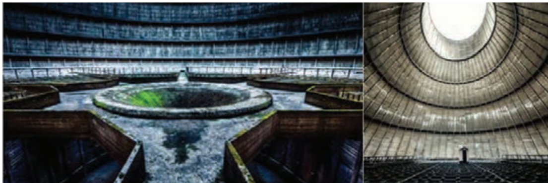
شکل ۲۰- خوردگی و رشد میکروارگانیسم‌ها در برج‌های خنک‌کننده
