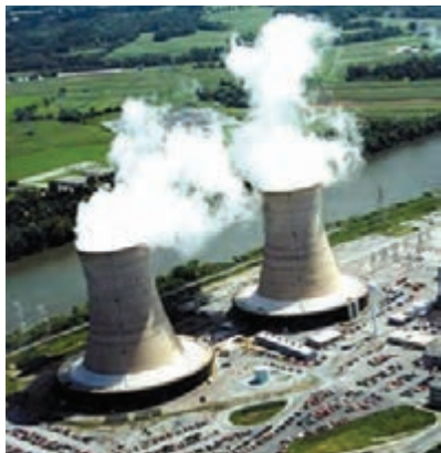
شکل ۳- نمونه‌ای از سامانه خنک‌کننده گذرا در مجاور رودخانه‌ها
