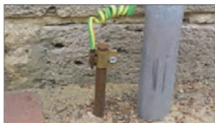
شکل ۴ - شیوه اتصال به چاه ارت
