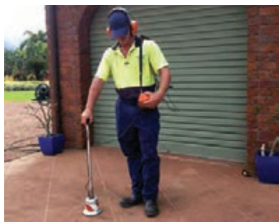
شکل ۹- تشخیص نشتی آب با دستگاه نشت‌یاب فراصوت ۱
