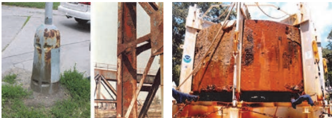
شکل ۵- نمونه‌هایی از خوردگی جو
